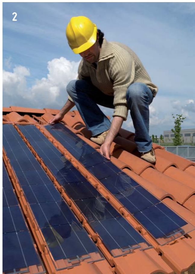
Innesto del modulo fotovoltaico
