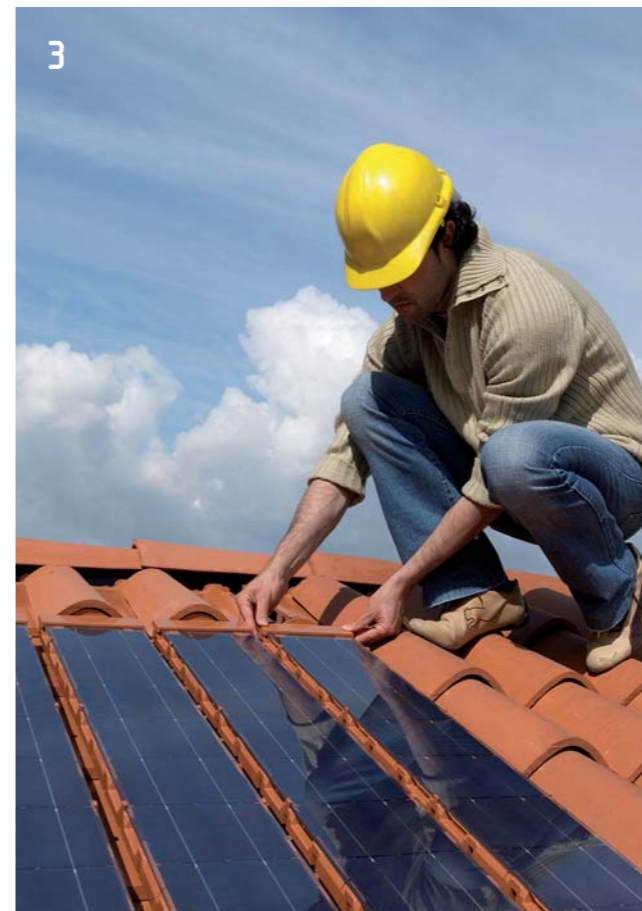
Fissaggio del modulo mediante apposita clip di chiusura
